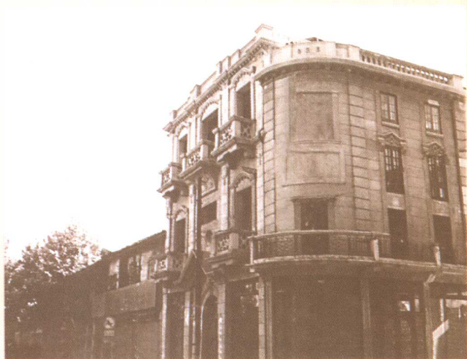
清河坊“四拐角”建筑原貌之一角
