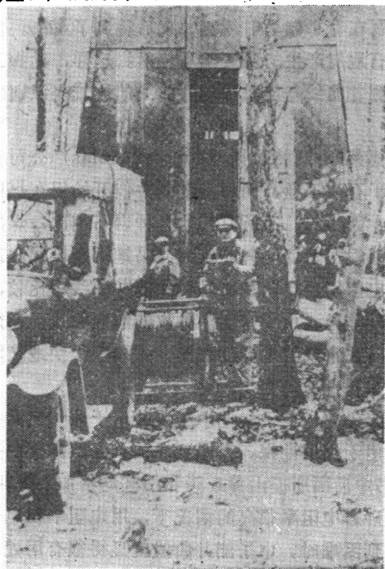
图 1.1 加拿大斯伦贝谢公司提供的一幅早期测井作业照片
