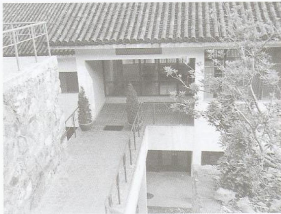
图5 四号疗养楼入口
