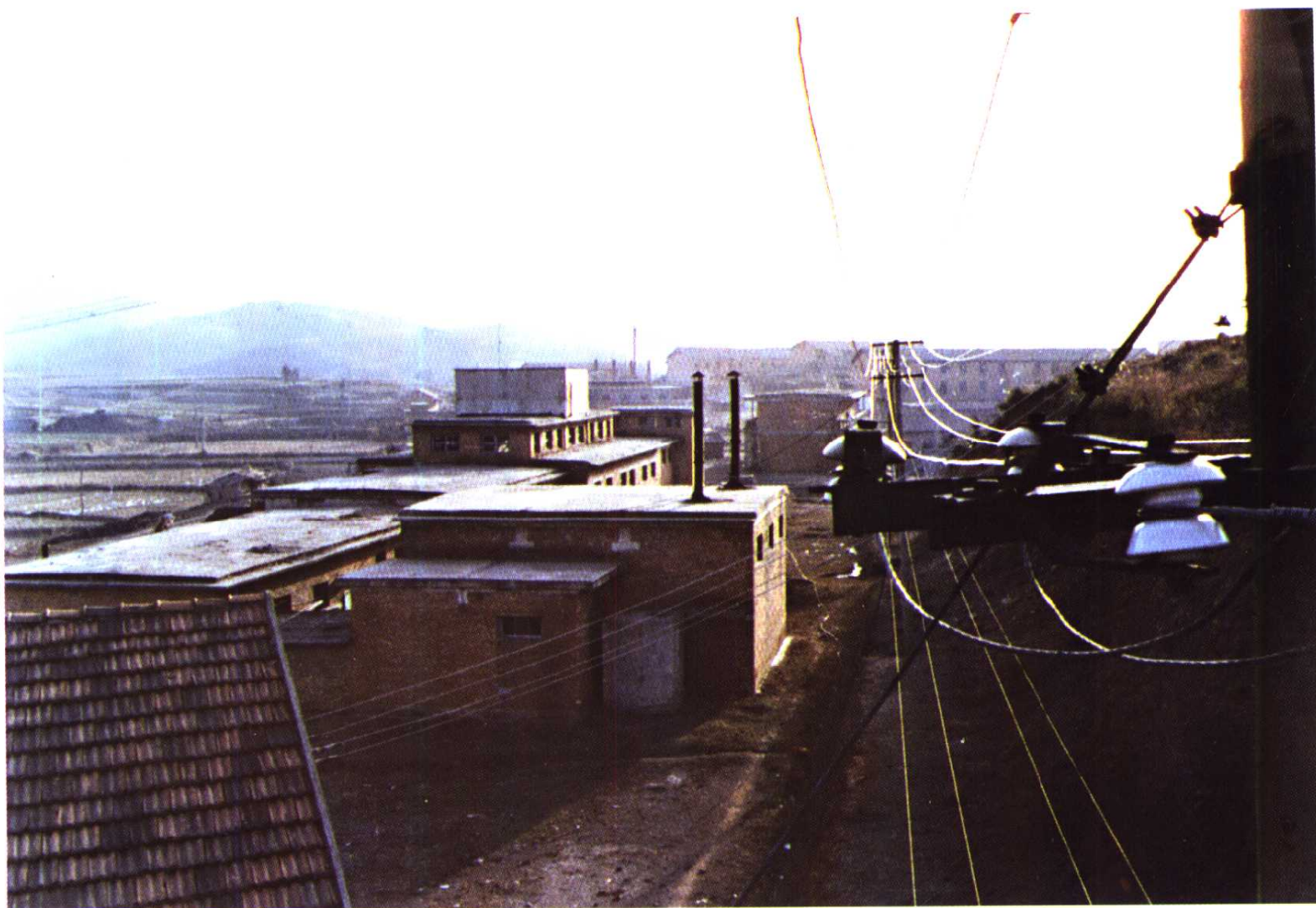
建设中的湖北省七约山煤炭矿务局瓦嘴矿井(年产15万吨)一角
