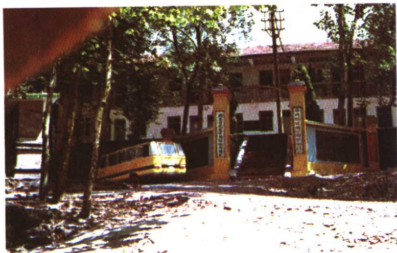
松宜煤炭矿务局庙河煤矿
