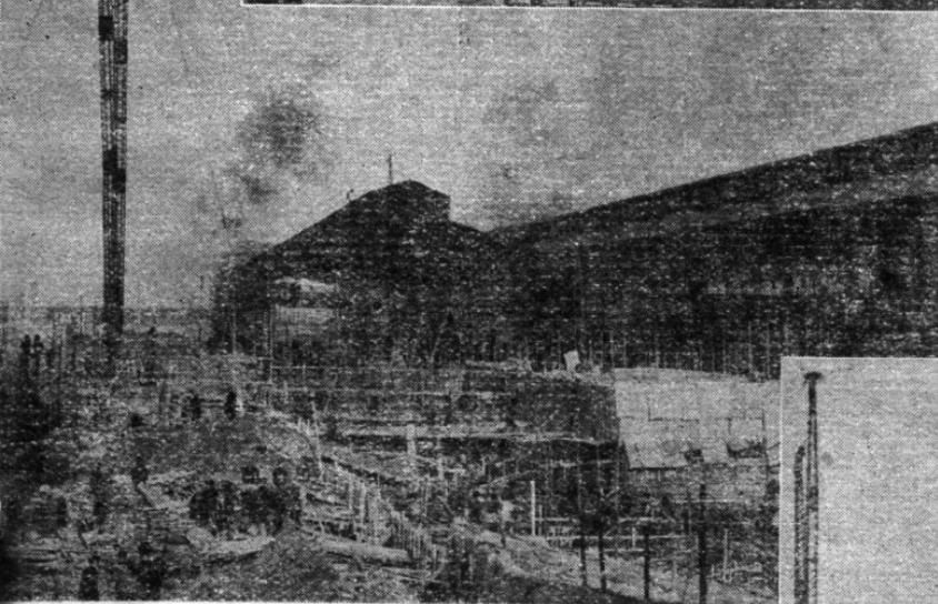
需要冬季施工的工程，要預先設計好這些工程施工時所需要的特別條件、組織方法和施工方法。左圖是鞍鋼工人們正緊張地勞動着，為冬季施工蓋搭取暖用的棚。
