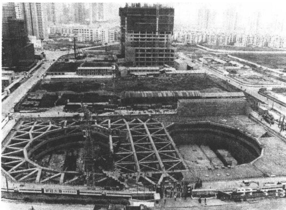
图3 排架及拱形支撑
