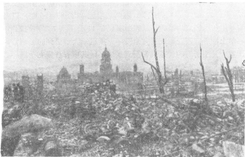
图 4 从諾布山南坡看旧金山市政大厦破坏情况
