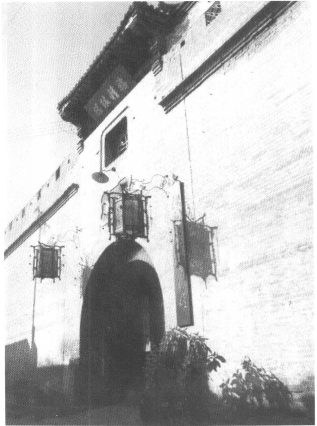
山西祁县巨商旧址，明清著名民居乔家大院
