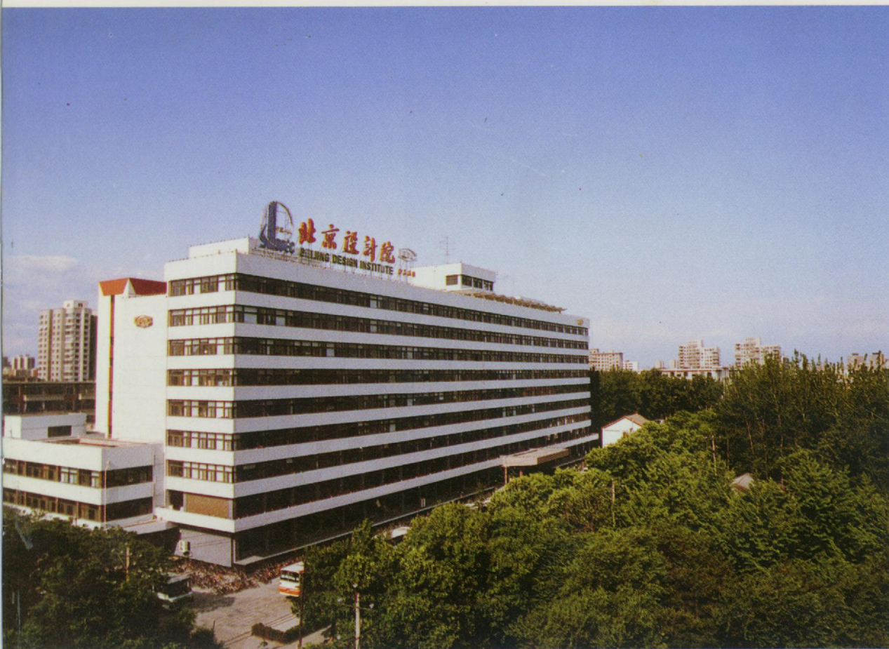
中国石化北京设计院业务楼全景
