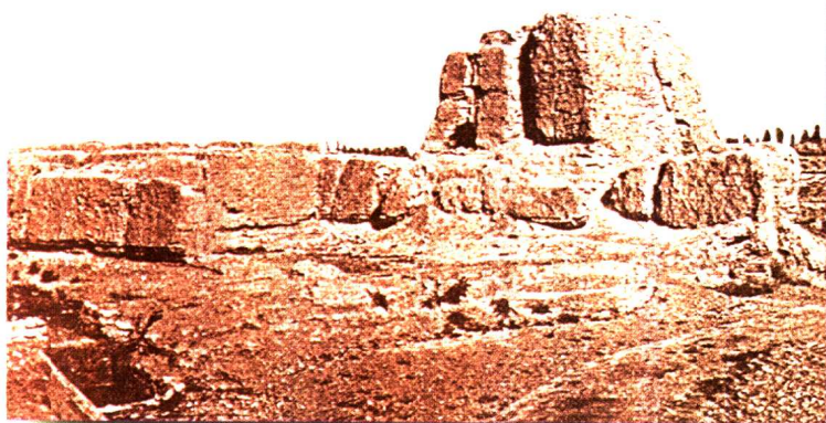
河西走廊上的烽火台
