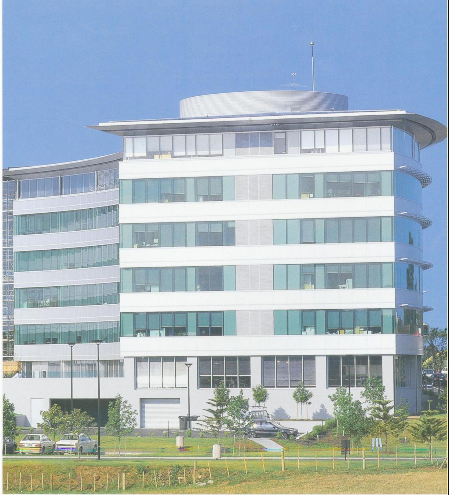
大楼的曲线造型增添了空间的趣味性，也带来了一些施工难度。例如安装吊顶板时就更加困难。
