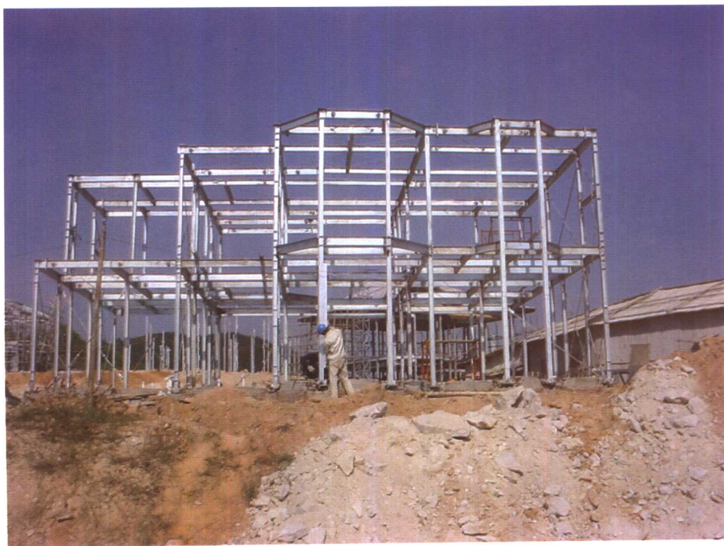
图 1.1-6 装配中的 H 型钢住宅钢骨架 (二)
