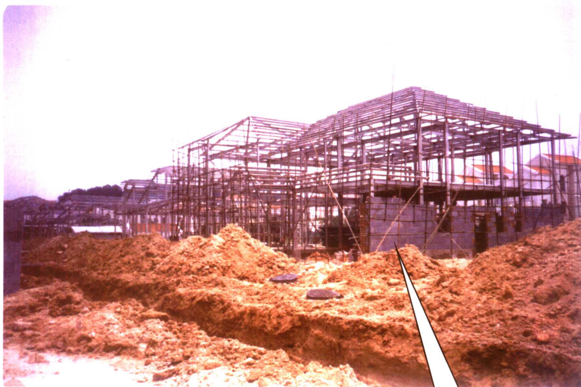
图 1.1-7 部分维护墙体
