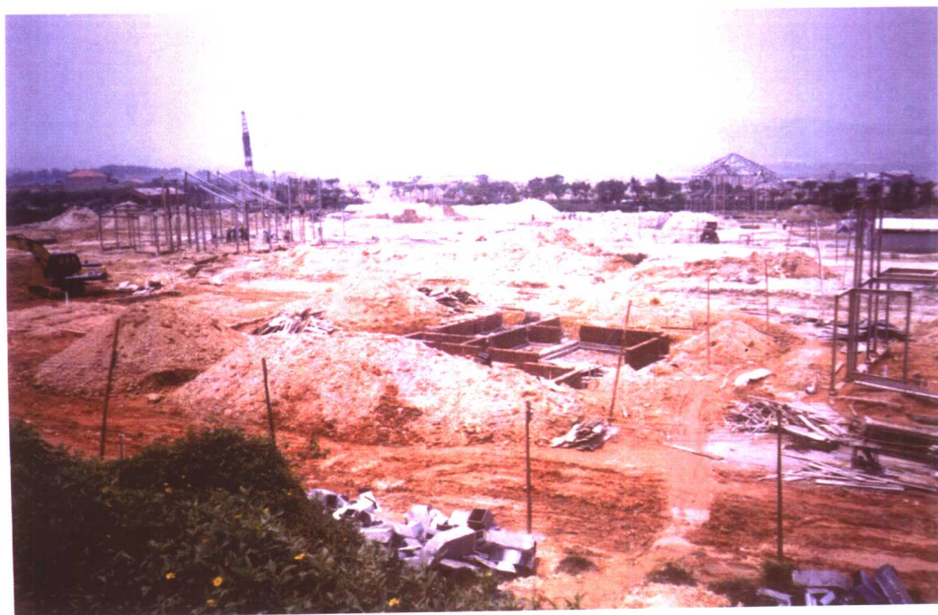
图 1.1-2 建造中的 H 型钢住宅基础
