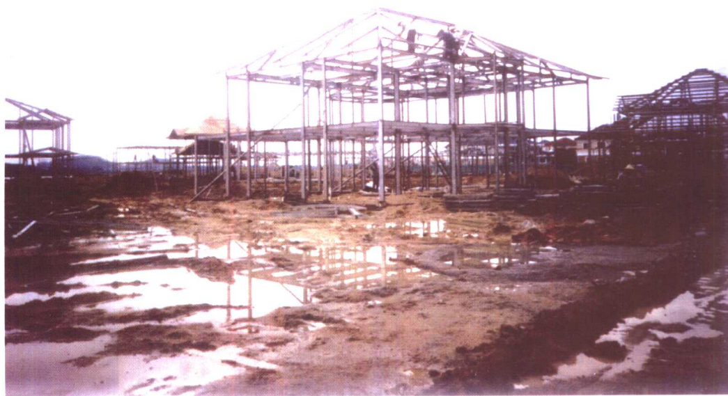
图 1.1-5 装配中的 H 型钢住宅钢骨架 (一)
