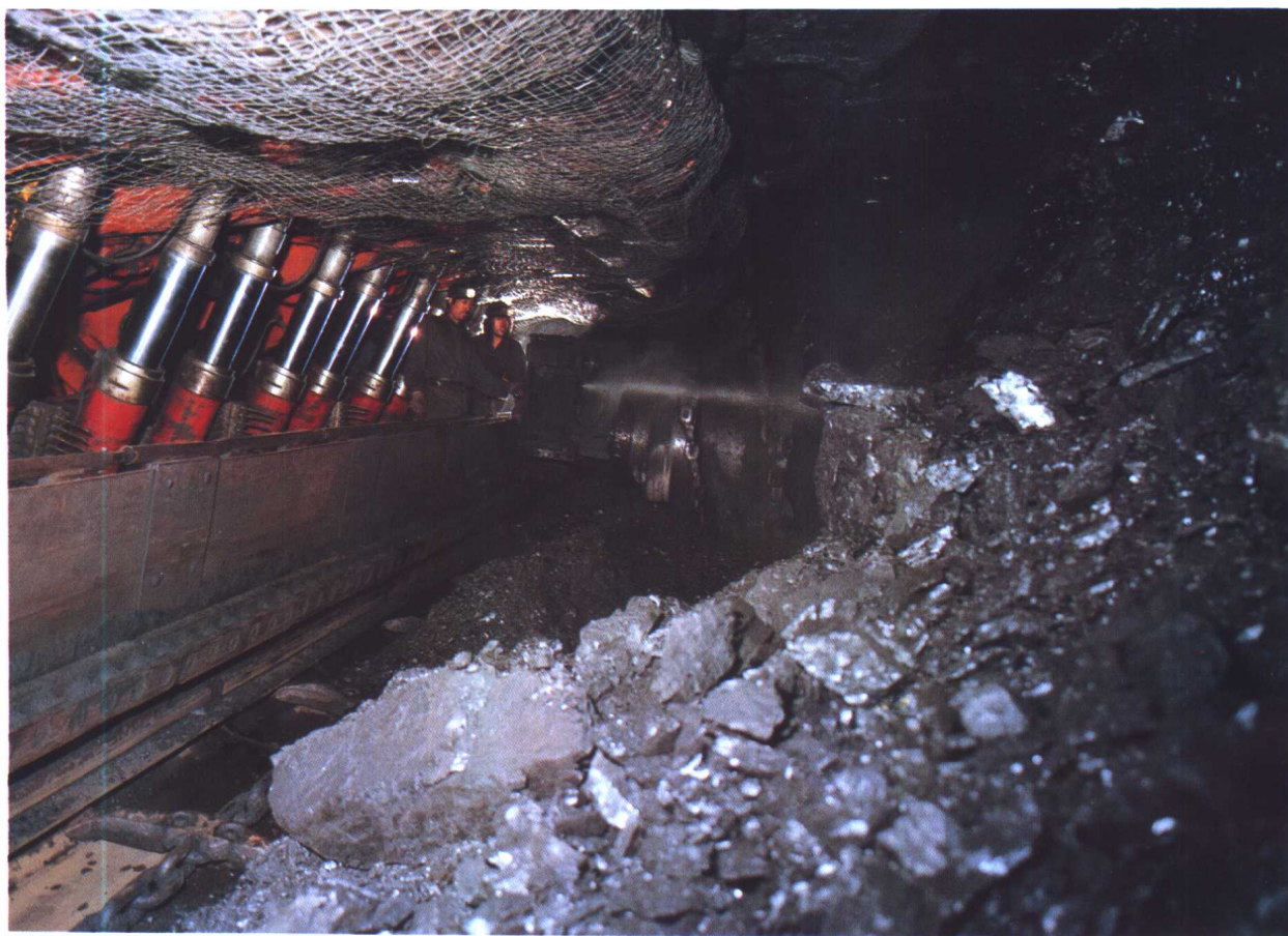
唐山矿金属网下综采
