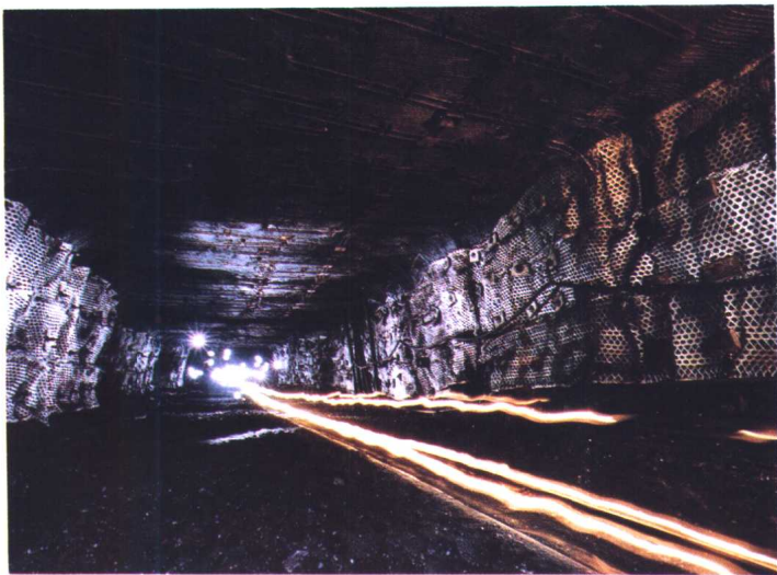
东庞煤矿大断面锚网支护的综采设备开切眼
