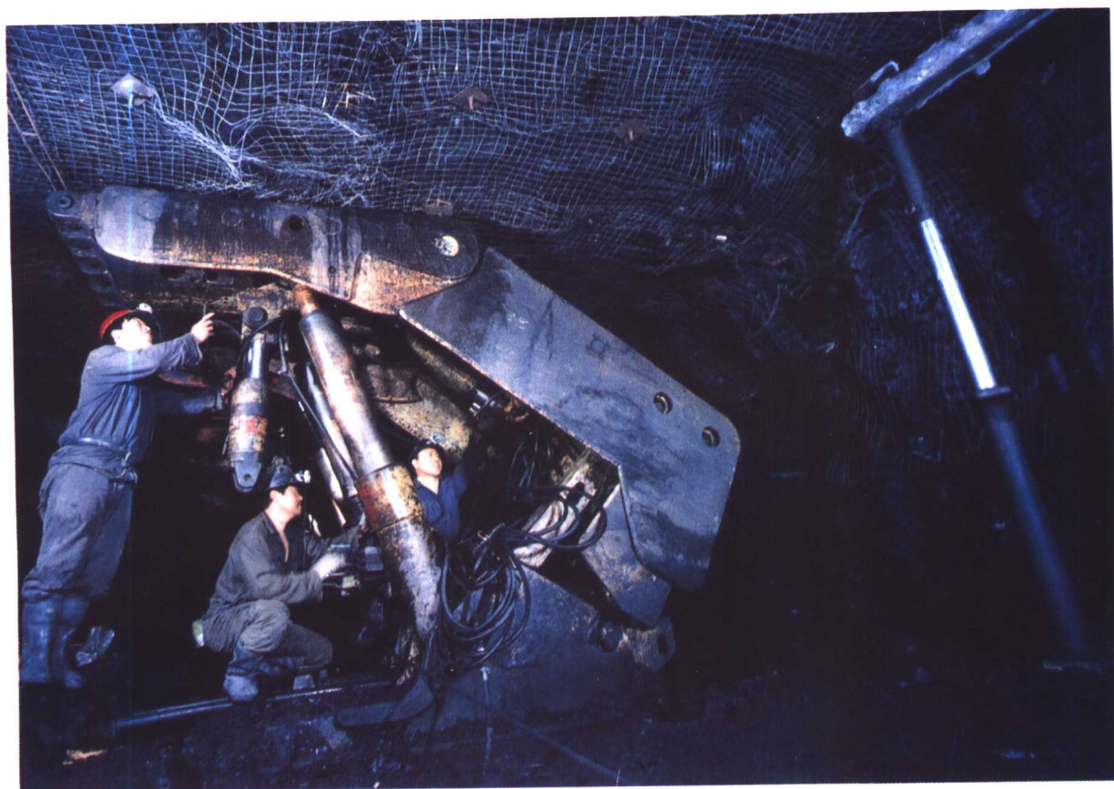
钱家营矿综采工作面设备安装
