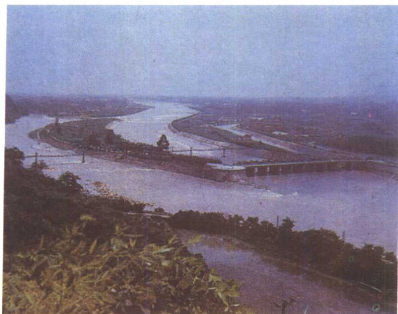
魚嘴——都江堰分水工程
