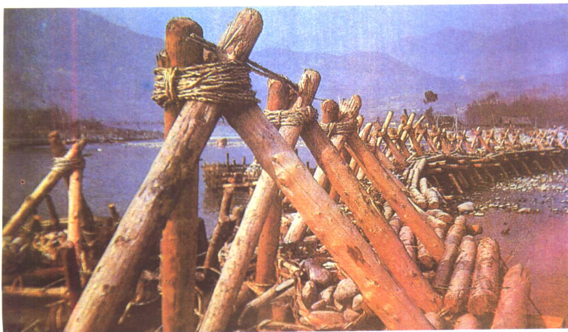
杗槎,用於擋水截流、防冰的木竹石結構
