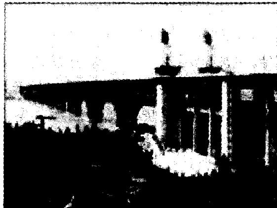
作为公路铁路两用桥，南京长江大桥的铁路桥面铺设长钢轨无缝线路，公路桥面由混凝土板及钢纵梁构成，混凝土行车道板的粗骨料采用粉煤灰陶粒，具有质地坚而重量轻的特点，比普通混凝土轻 20%~25%，这是我国首次在特大桥梁上使用轻质混凝土。桥址地质复杂，分别采用 4 种基础：① 位于浅水而覆盖层深厚墩位处，采用重型混凝土沉井，穿越深度达 54.87m，在国内首创纪录；② 在基岩好而覆盖层较厚墩位处，选用钢板桩围堰管柱基础，并首次采用大直径 3.6m 先张法预应力混凝土管柱；③ 在基岩较好、覆盖层较厚但水位甚深的墩位处，采用首创的浮式钢沉井加管柱的复合基础；④ 在水深、覆盖层厚但基岩强度较低的墩位处，采用浮式钢筋混凝土沉井，其上部为钢筋混凝土结构，下部为钢与钢筋混凝土组合结构，利用钢气筒充、泄气来浮托纠偏，清基潜水作业深达 65m。
