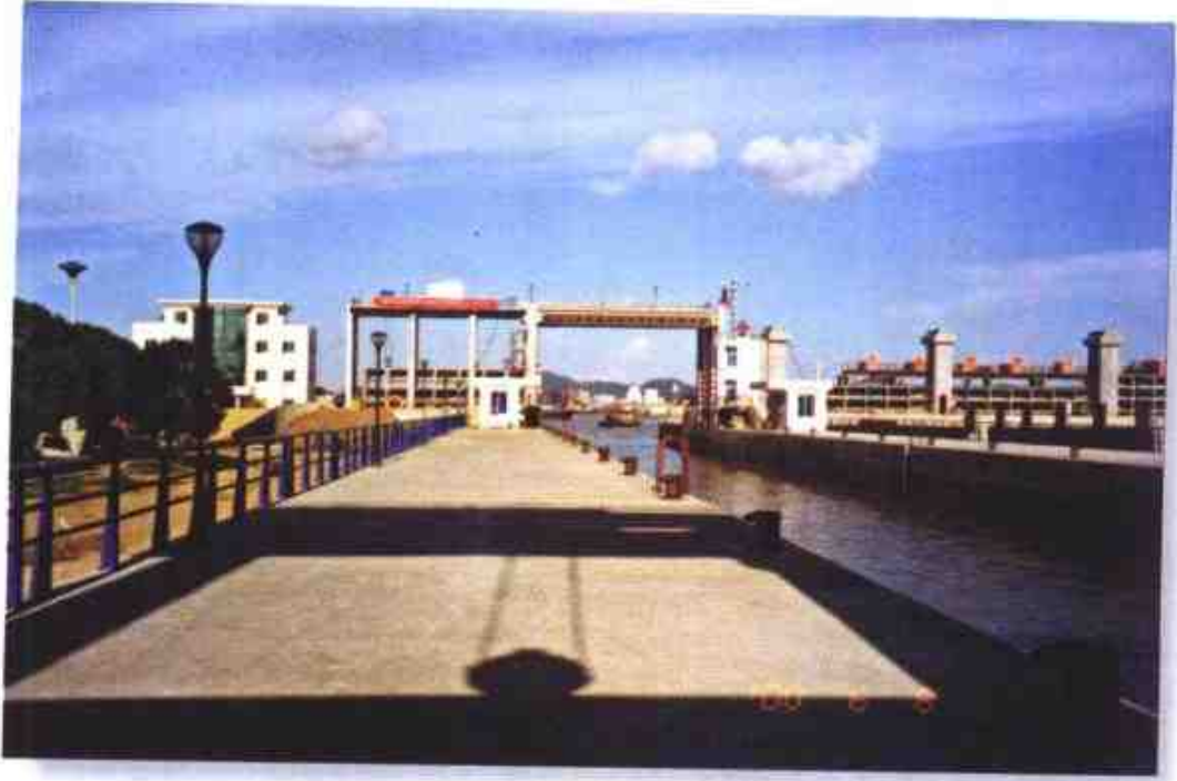
东河水利枢纽工程
