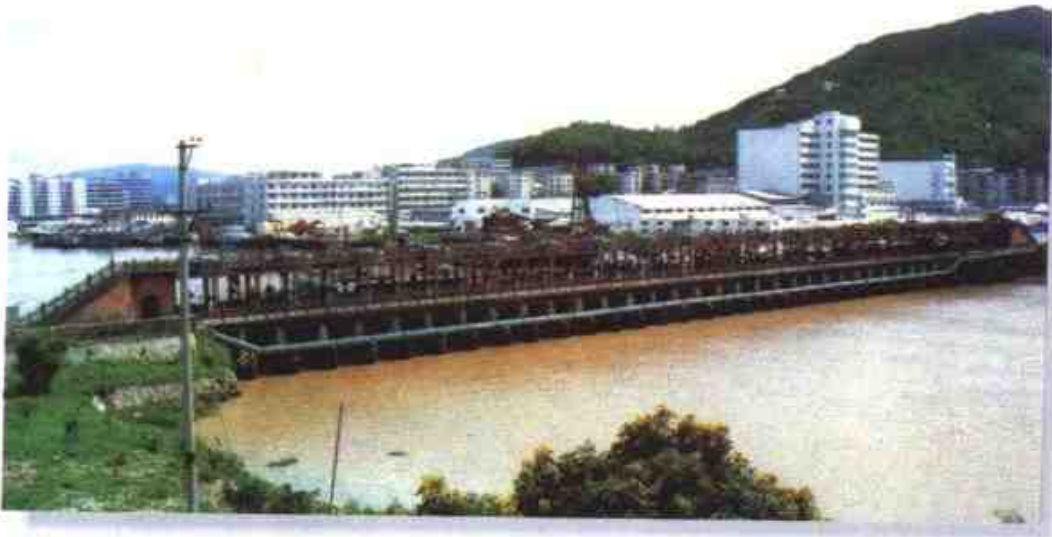
中珠联围石角咀水闸29孔净宽91米
