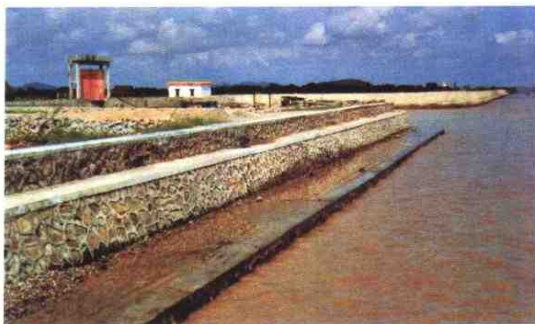
张家边联围三级海堤砌石，可抵御台风暴潮以及频繁的高速船浪冲击。
