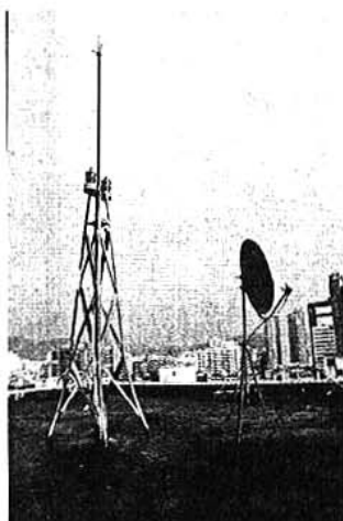
图 1.8 不要安装在避雷针及重要电气管线附近
