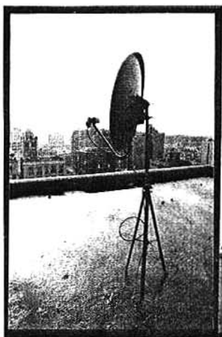
图 1.7 注意安装地点是否会积水，否则脚座容易锈蚀
