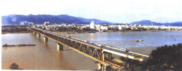
公路铁路两用西江大桥
