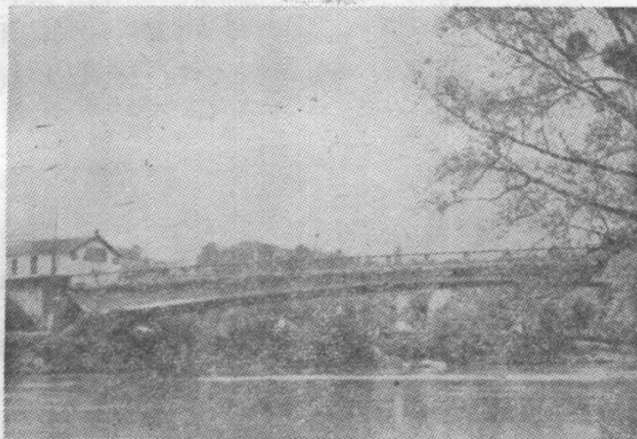
图1.1 在露占西跨越马恩河跨度为180英尺的桥梁，弗莱西奈设计，建于1941年
