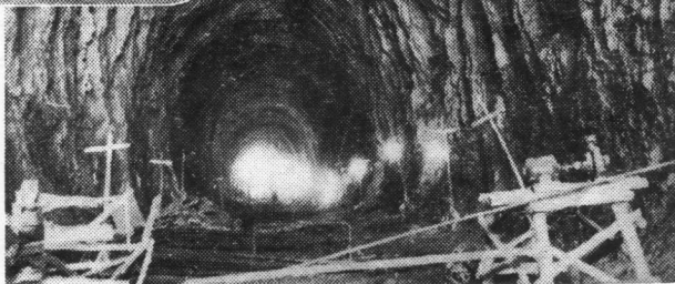
右：鑽石機鑽得石粉噴霧，炸藥炸得石塊石粉迸飛，使隧洞日益擴大伸長。
