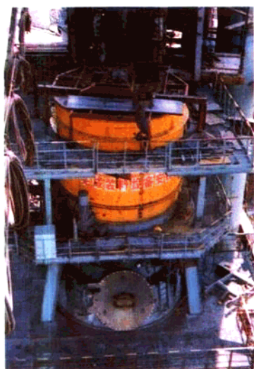
安装中的串罐无料钟
