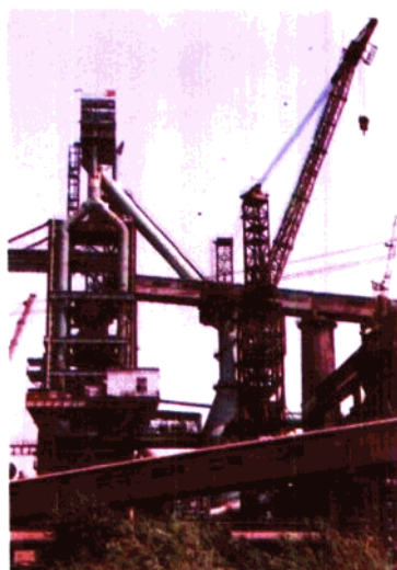
安装中的串罐无料钟
