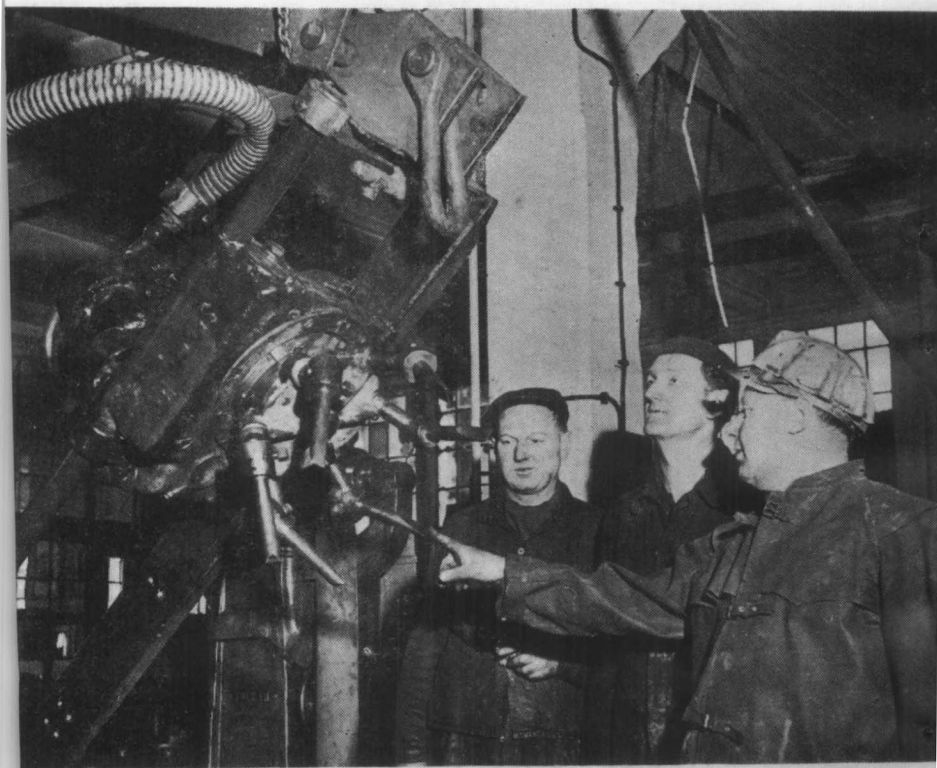
捷克斯洛伐克的煤炭工业按人口平均计算产量已跃居世界第一位。图为俄斯特拉发的“胜利的二月”煤矿里按装国产的新式联合采煤机。
