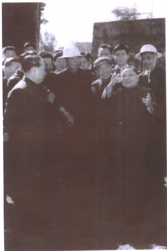
1978年9月，邓小平同志 在大地震发生两年后的唐山 施工现场。
