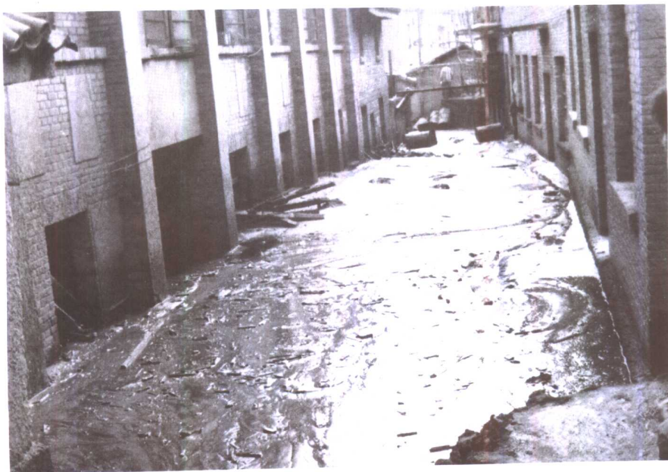
云南省东川市因 民区供销社办公楼被 泥石流淤埋。
