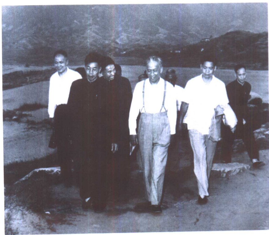
1960年，刘少奇同志视察长江三峡大坝坝址钻探工地。
