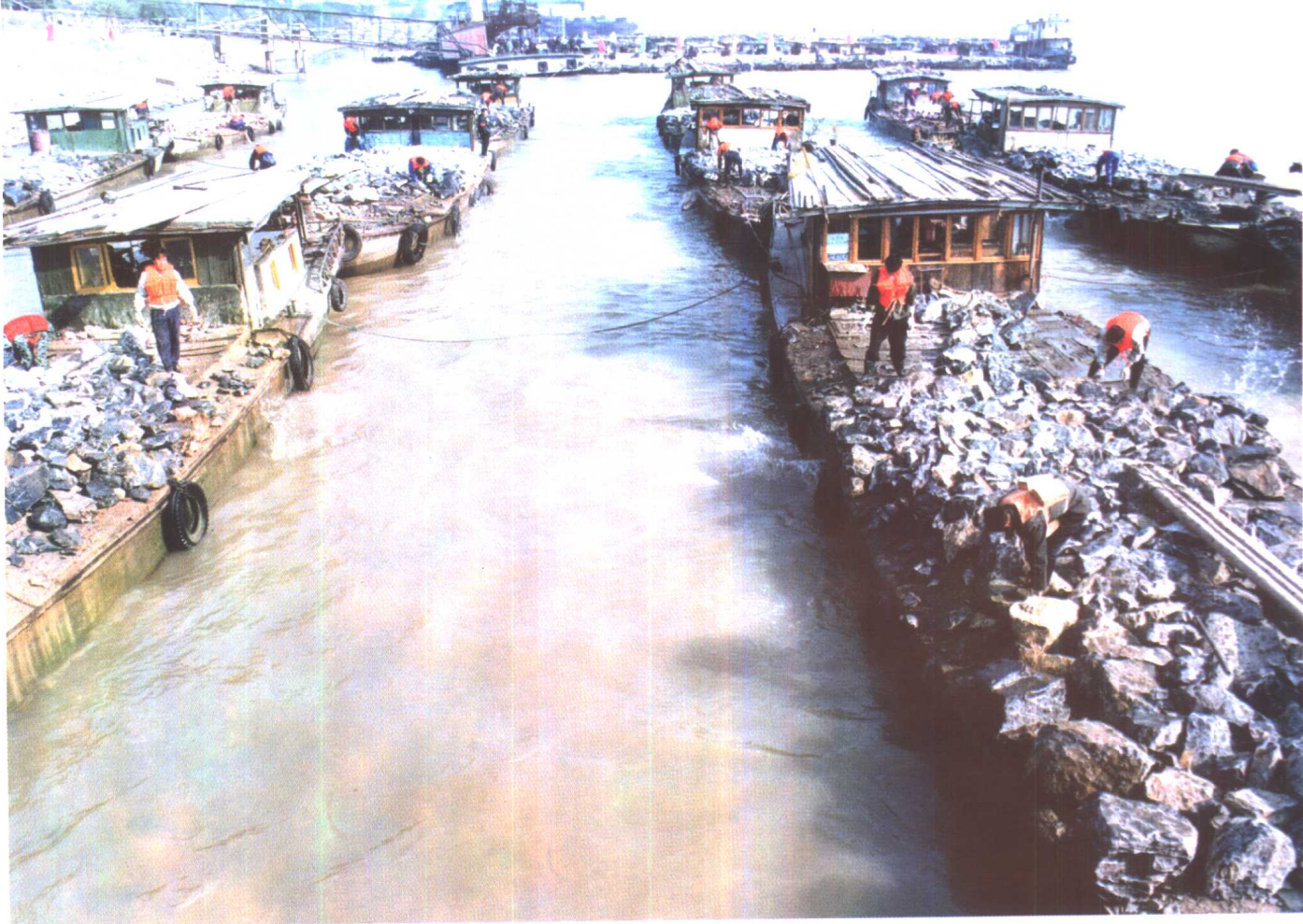
抗洪斗争中，南京浦口下关沉排加固工作抛石现场。
