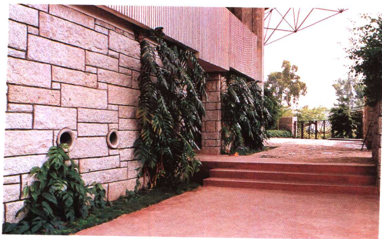
从南门厅到东门厅的过道
