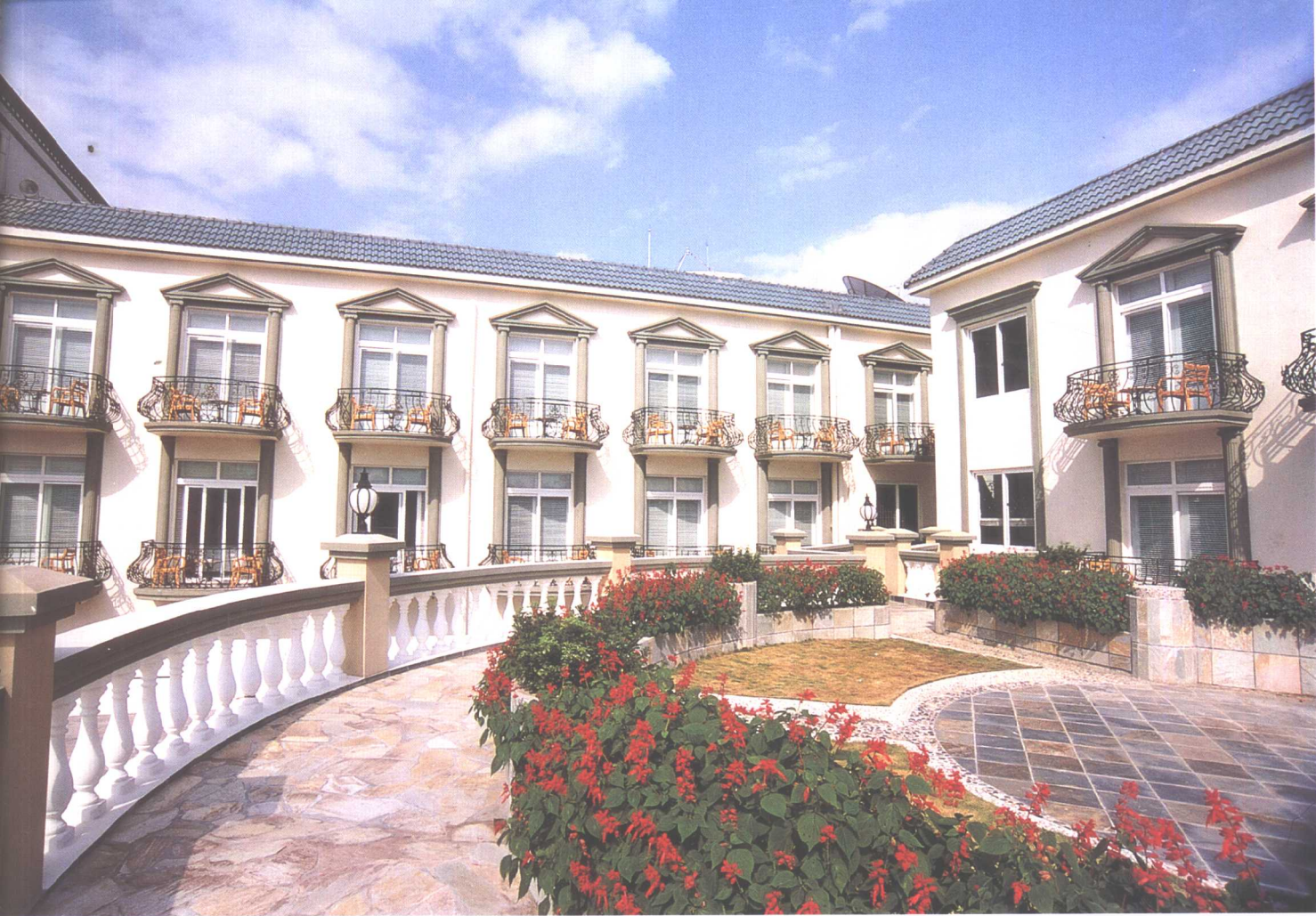
走廊地面铺设砂岩片，从这里可通向客房走廊。
