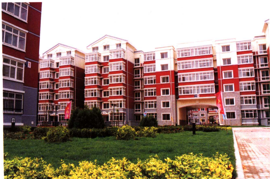
田华公司承建的回龙观小区 A06 组团 14 栋住宅楼
