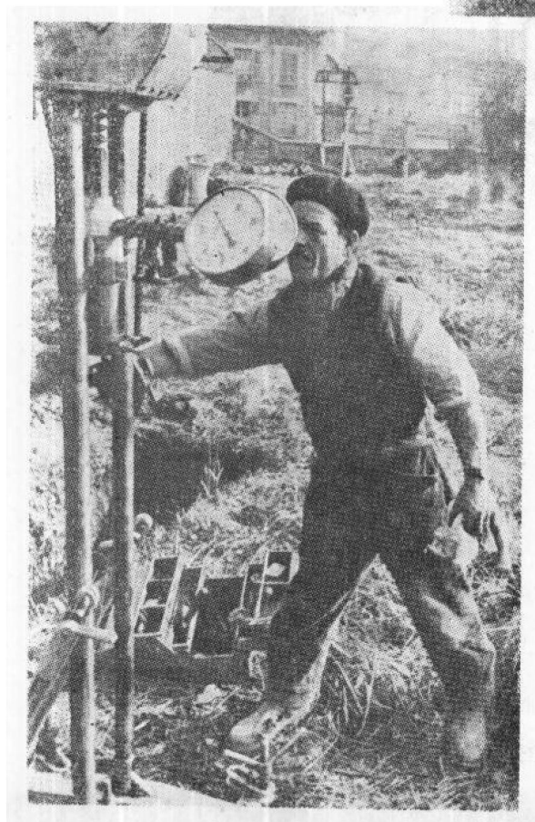
图 1-6 2.5吨能量的荷兰式触探仪
