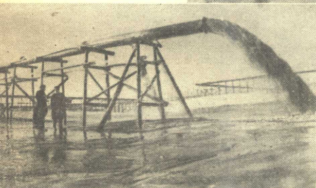
右：水電站建築中打地基掘壕溝用的吸泥機。
