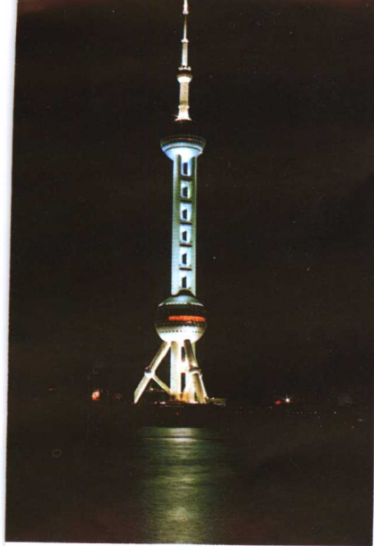
▲上海东方明珠广播电视塔
