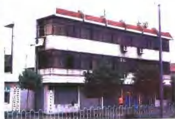
(21) 余姚市气象局办公楼。
