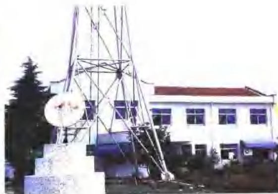
(20) 慈溪市气象局办公楼、卫星天线通信铁塔。
