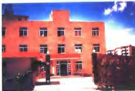
(19) 鄞县气象局办公楼。
