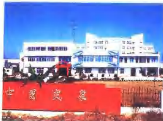
(23) 宁海县气象局办公楼。
