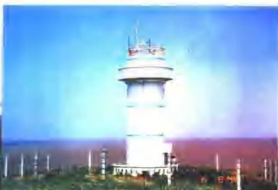
(41) 宁波市气象局为杭州湾跨海大桥建设而设立的杭州湾自动气象站。
