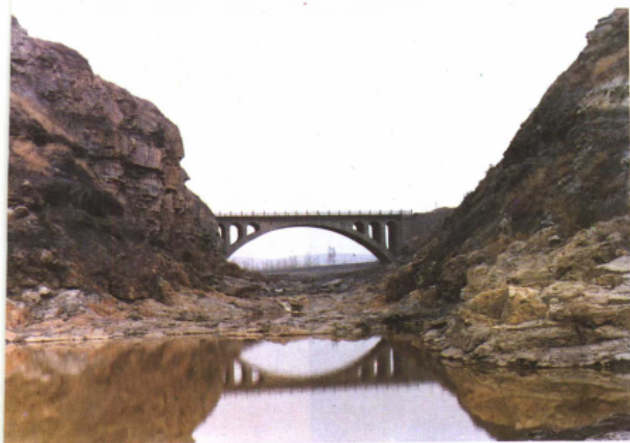
润城劈山改河工程
