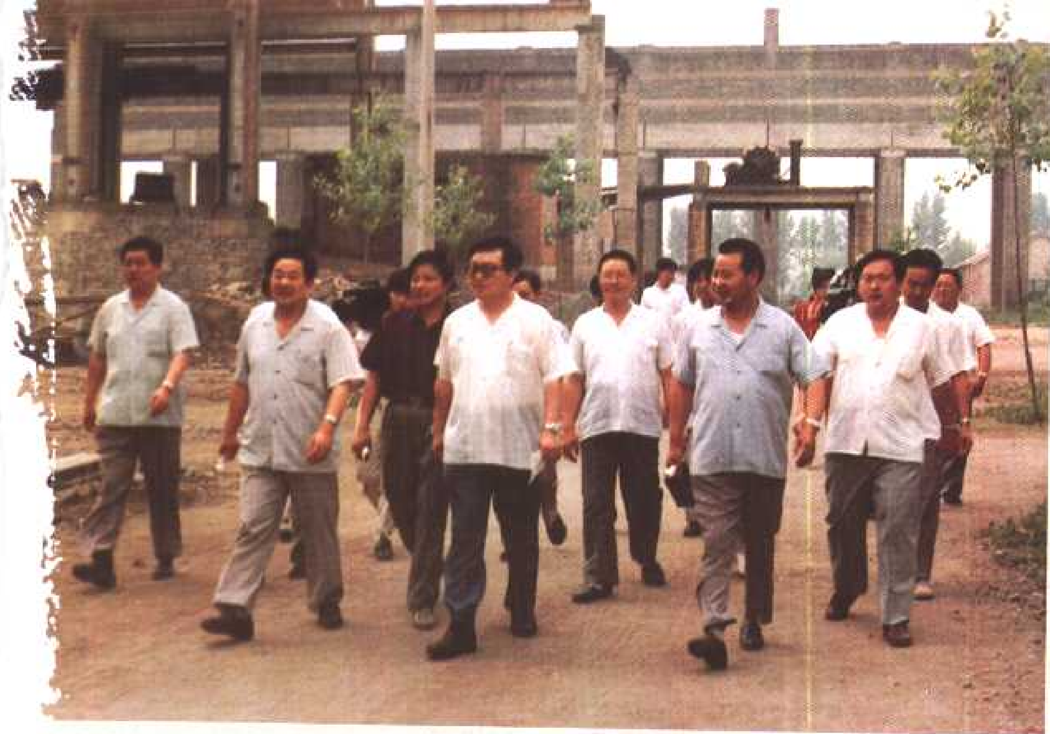
◀ 中共河南省委书记李长春(前排中), 由马怀卿、陈协义、张柳松 陪同视察鲁山钢铁厂 工地
