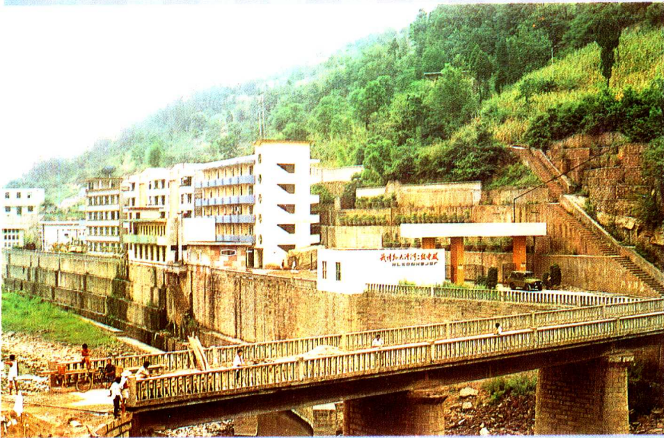
◀大溪河二级电站全景
