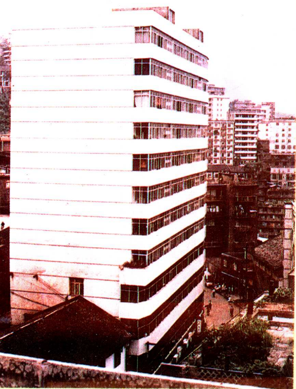
◀ 县粮食局大楼
