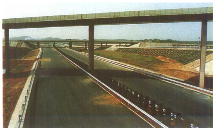
在建的京珠国道湖北段
