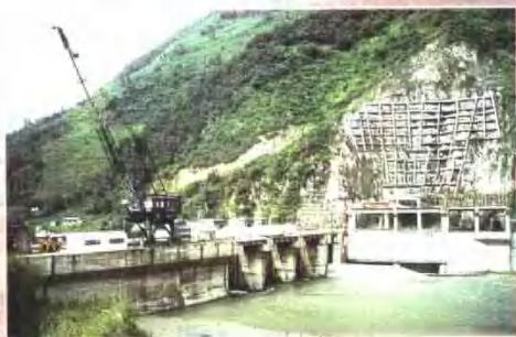
华能小关子电站大坝
