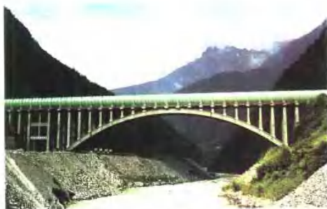
华能小关子电站输水管道
