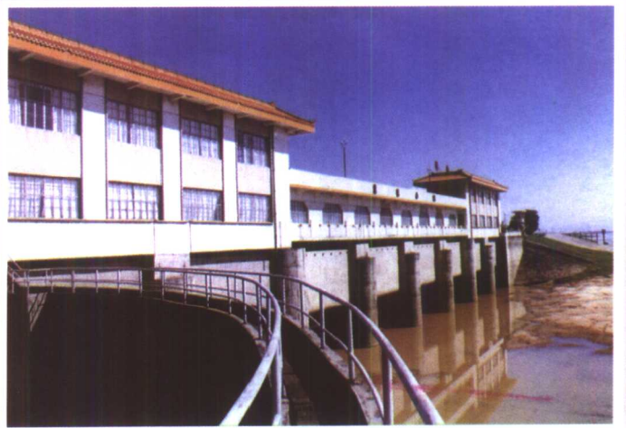
三水芦苞排泄水闸
