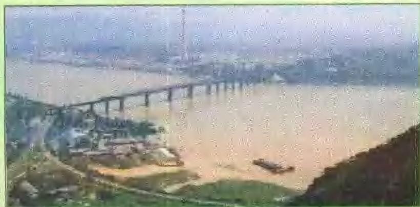
川黔铁路的白沙沱长江大桥
