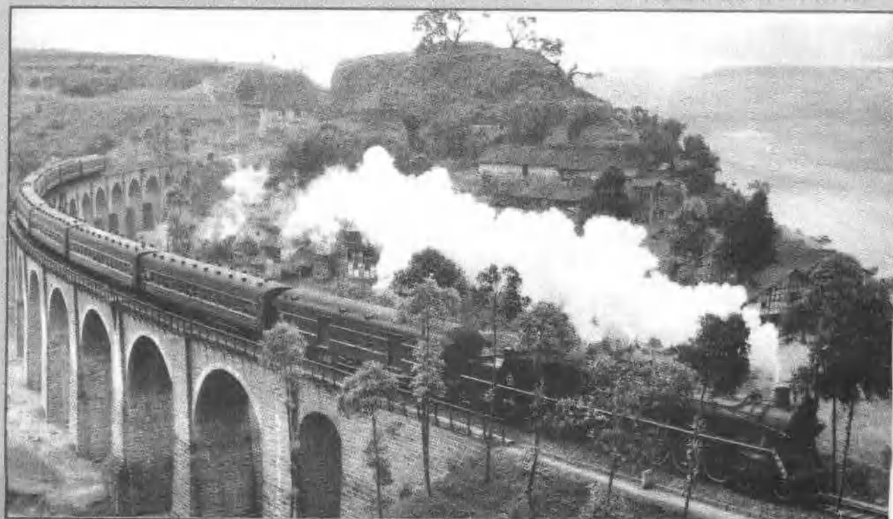
列车通过成渝铁路王二溪大桥
