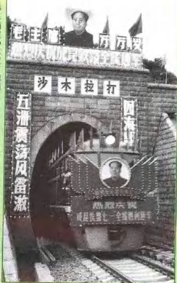
彩车通过沙木拉打隧道
