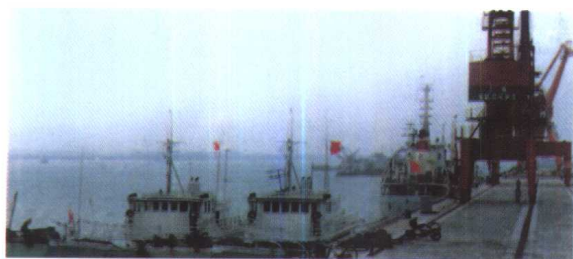
水东港一万吨级集装箱码头
