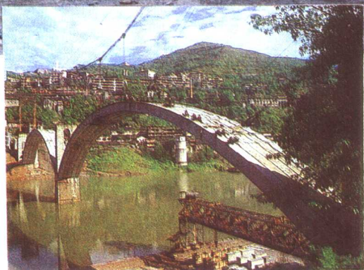
◀ 正在修建中的通河大桥
