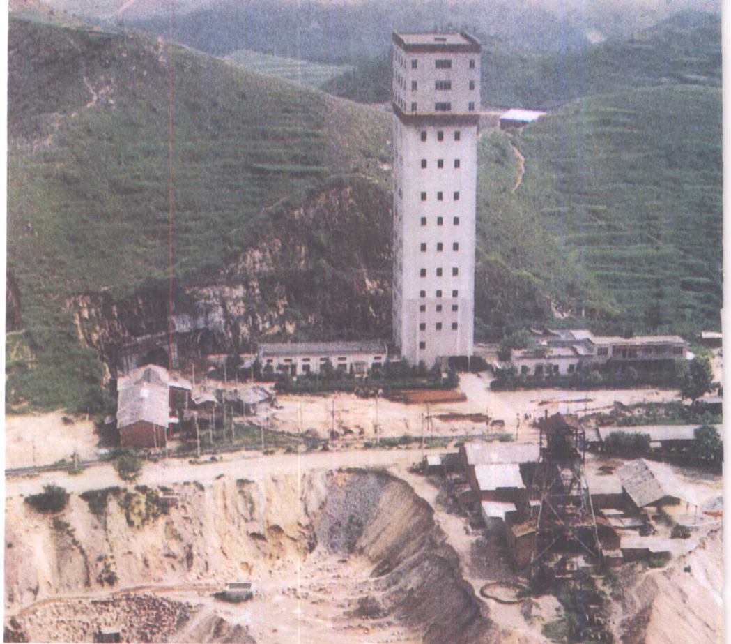
程潮铁矿矿区
