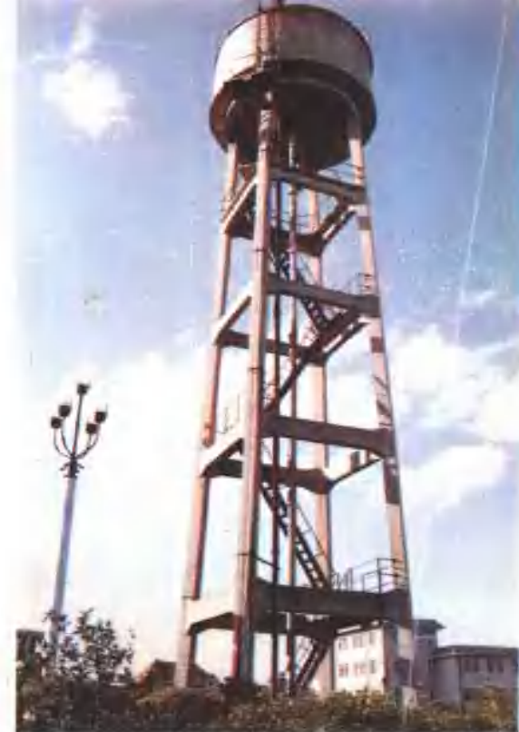
●高南乡自来水厂及水塔
