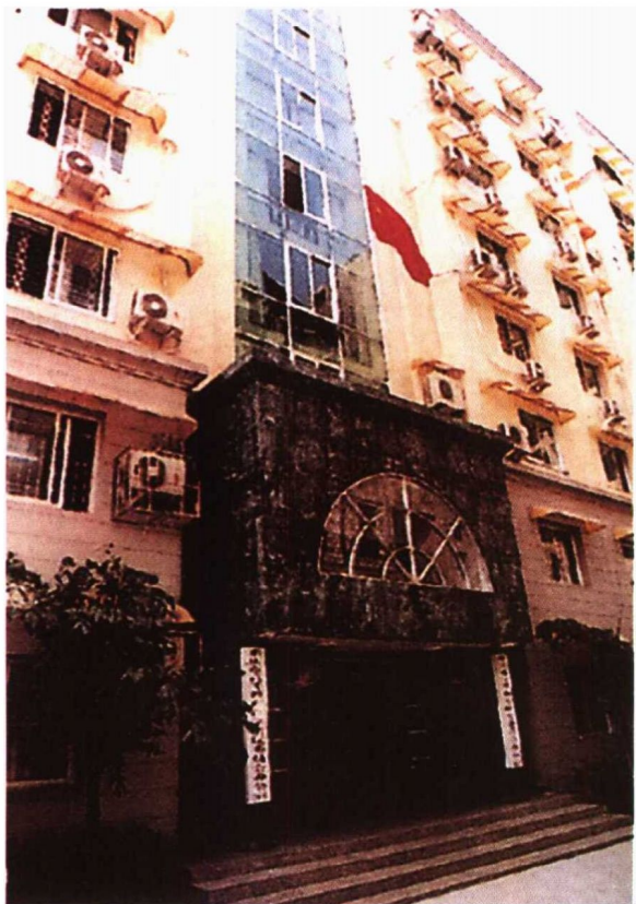
新招生考试办公楼
