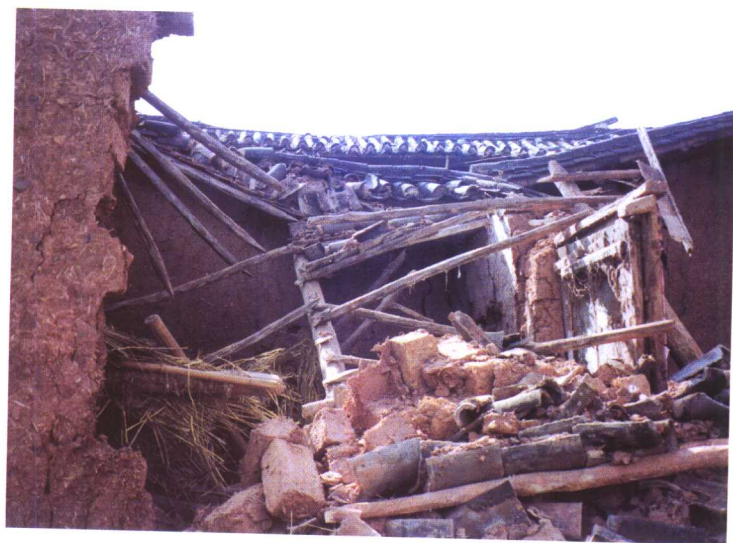
2000年1月15日云南省姚安县发生6.4级地震，官屯乡土木民房墙体倒塌
