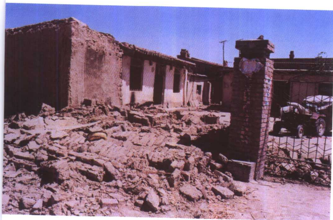
2000年6月6日甘肃省白银地区景泰县发生5.9级地震，兴泉堡乡土坯围墙倒塌情况
