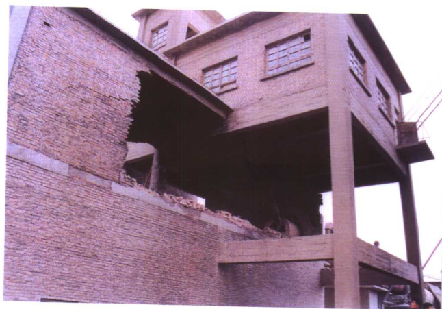
兴泉堡特种水泥厂砖墙倒塌毁坏情况
