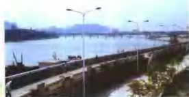
已建防洪洪浪渡的柳州市河西防洪大堤
