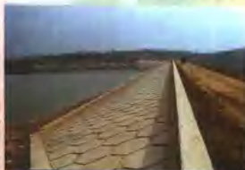
完成除险加固工作的南宁市郊区延安水库
