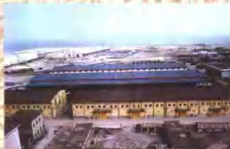
新建的防城港中央粮食储备库。
