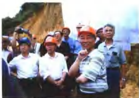
李里宁厅长陪同水利部部长江恕德，自治区主席李兆坤察看百色水利枢纽工程前期施工现场。
