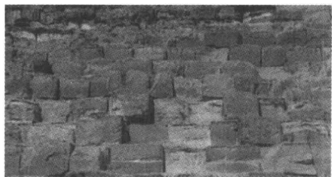
建造成金字塔的石块
