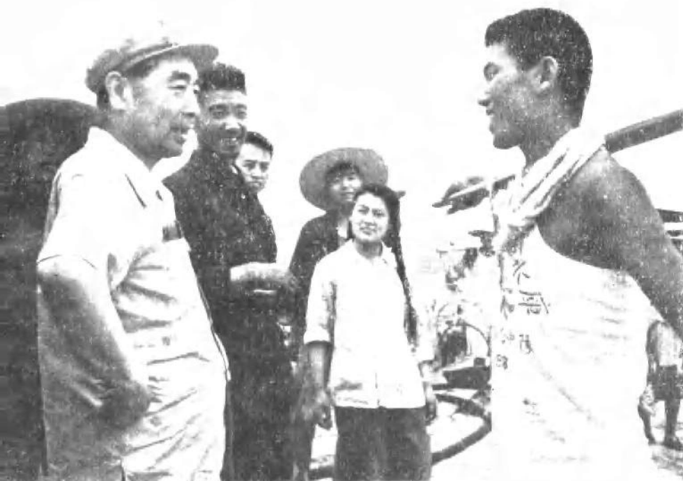
周总理在怀柔水库工地和民工谈话
