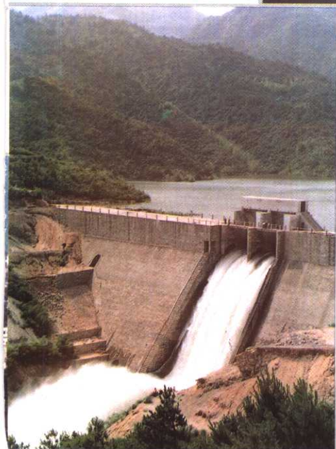
▼ 高塘坪水库大坝
