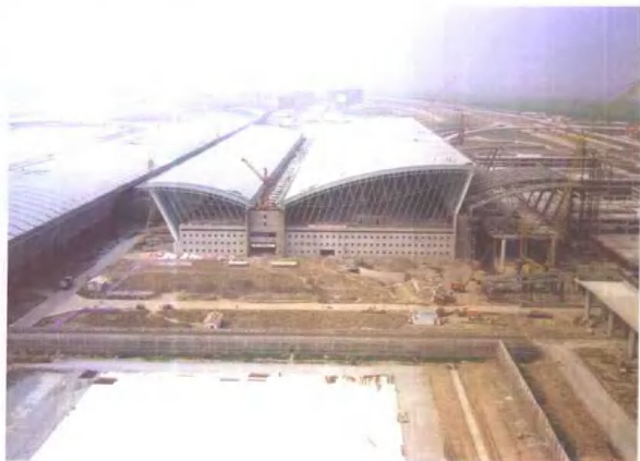
建设中的航站区鸟瞰
