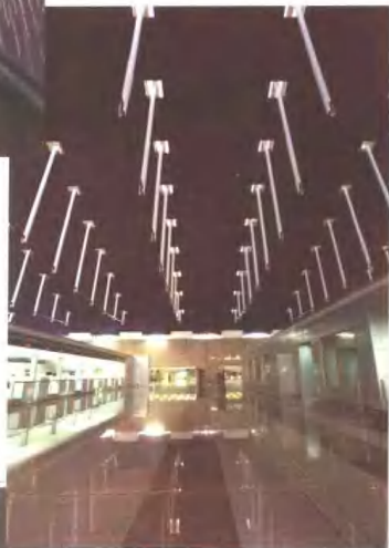
航站主楼出发层公共大厅屋顶
