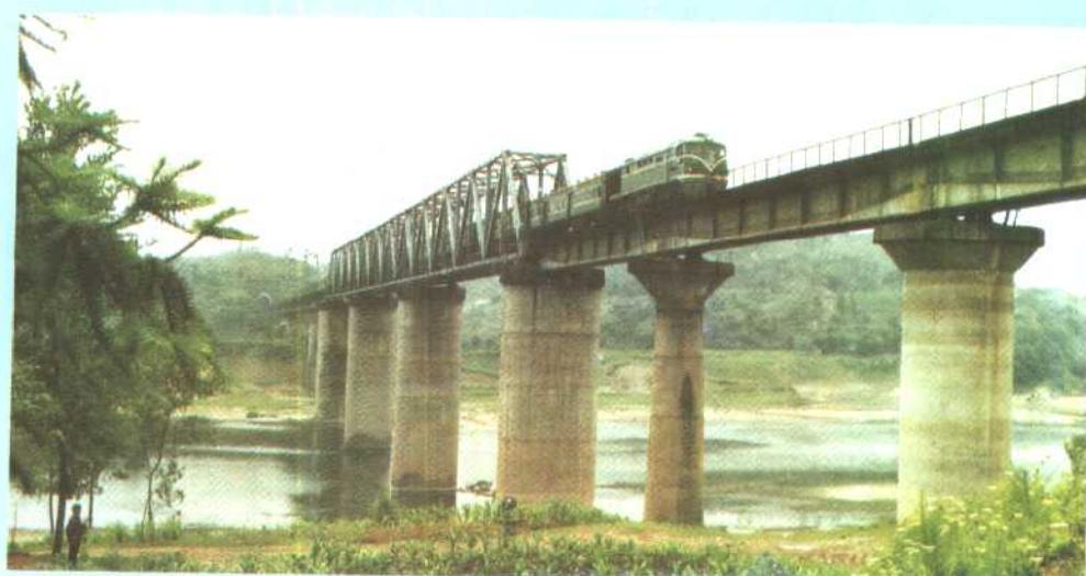
► 州河铁路大桥
