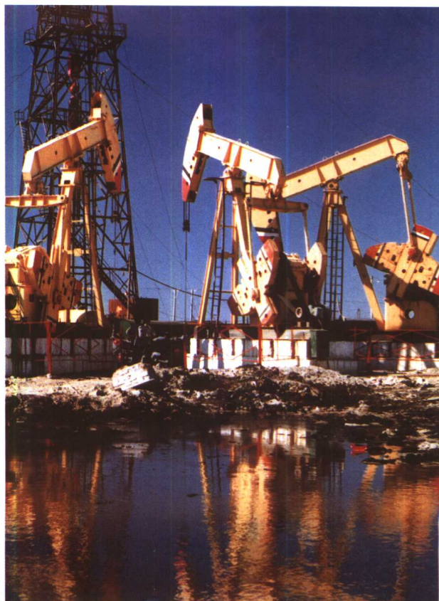
沈阳采油厂的丛式井组
